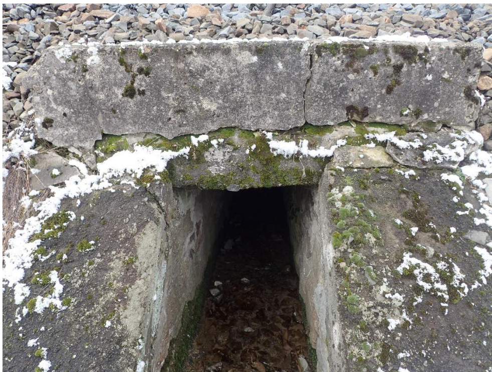
Foto 4: Trhlina na pravé římse propustku, degradace betonu
