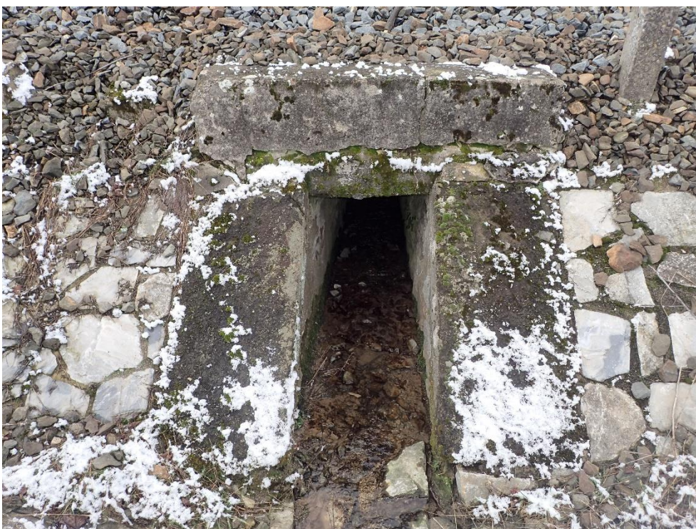
Foto 2: Pohled na vtok propustku
